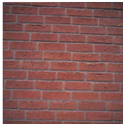
Figuur 7 – Klezoorverband met rechts vallende tand.
