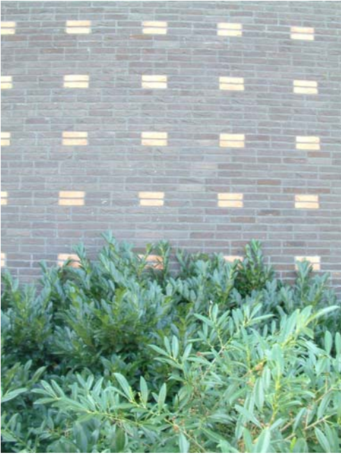
Figuur 4 – Variatie op halfsteensverband.
