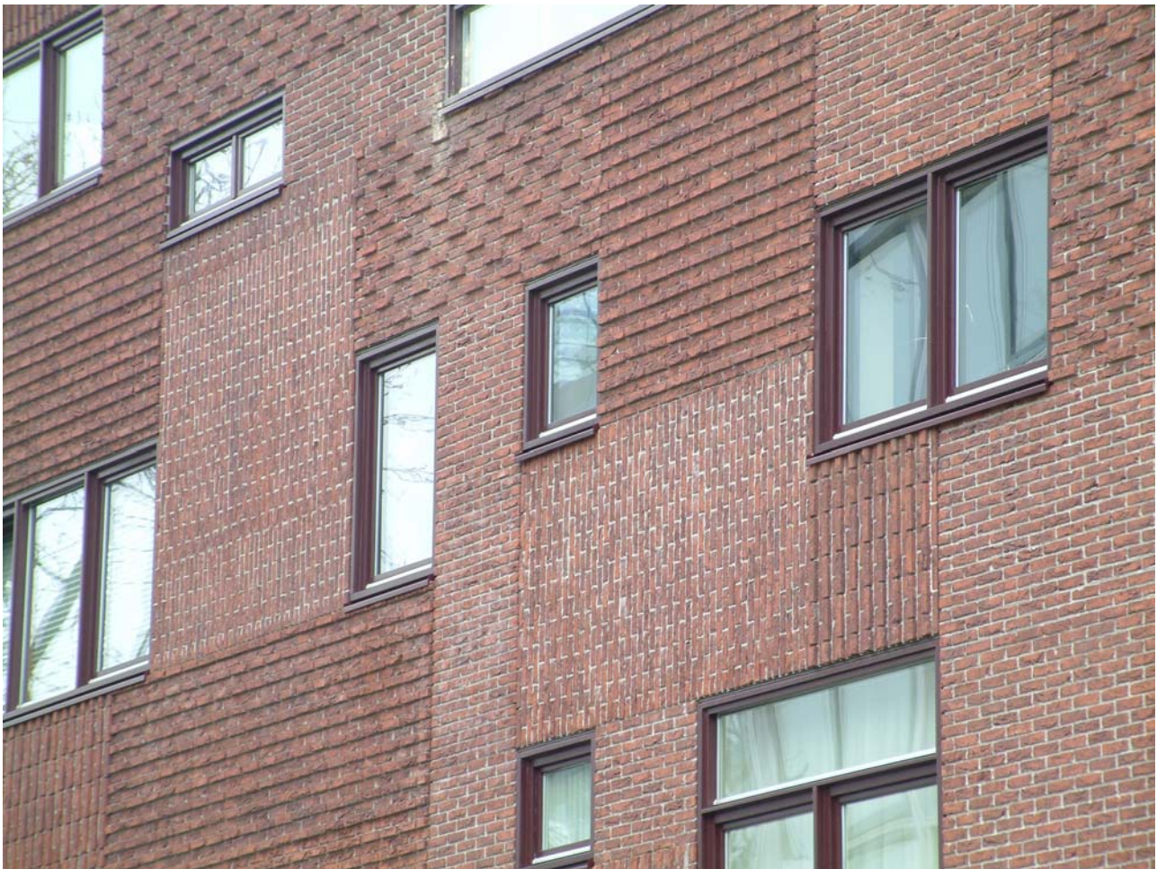
Figuur 19 – Fraai voorbeeld van de effecten die met metselverbanden al dan niet in combinatie met reliëf bereikt kunnen worden.
