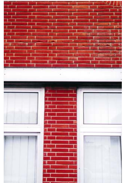
Figuur 14 – Noors- of kettingverband.
